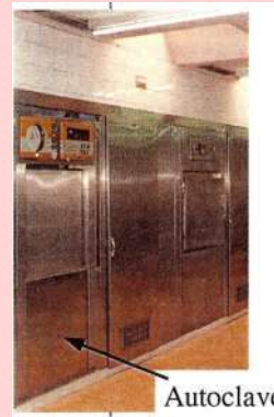
Central de Esterilización
